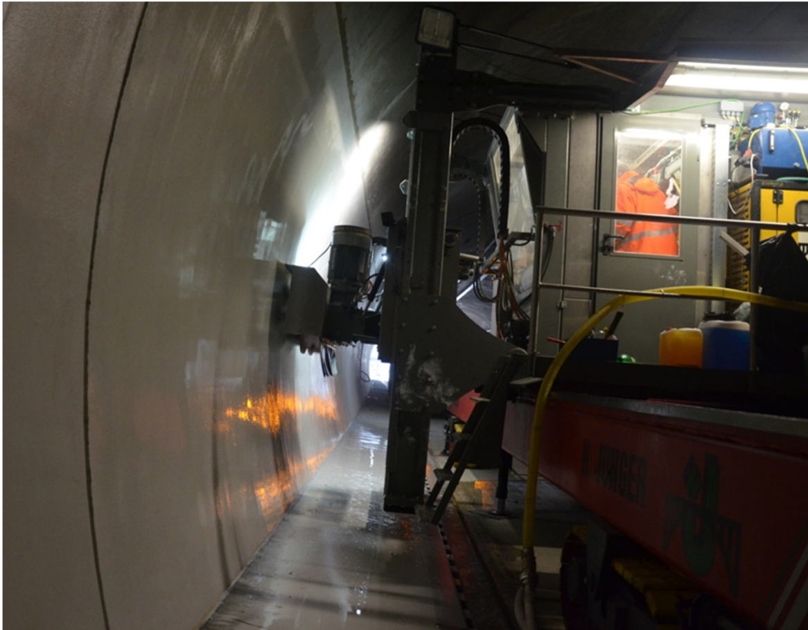
Bild 4: Schleifen einer Tunnelulme
