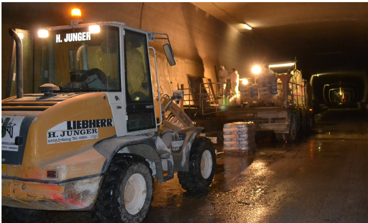
Bild 3: Mobiler Spritzhänger mit Mörtelpumpe
